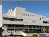
早良市民センター外観
